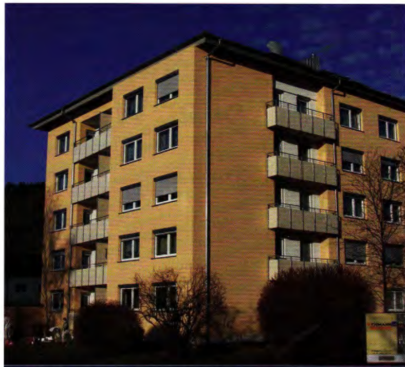
Das Ziel, mit dieser Sanierung die EnEV 2007 um 30% zu unterschreiten, wurde erreicht
