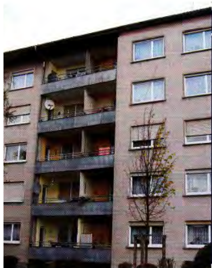
Zustand vor der Sanierung
