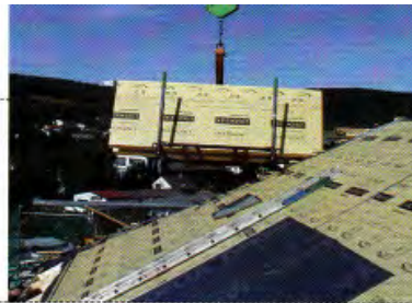
Das Dach wurde mit einer Aufsparrendämmung saniert
